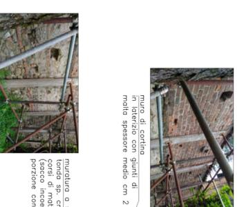
muro di confine in laterizio con giunti di malta spessore medio cm 2
